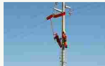
Villa Peduzzi lavori di Enel possibili disagi
